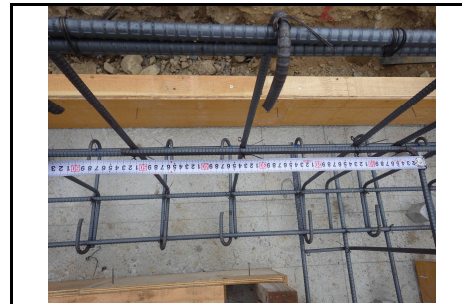
コメント 補強筋と主筋の緊結状況
