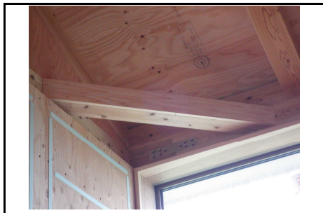
コメント 火打ち材設置
